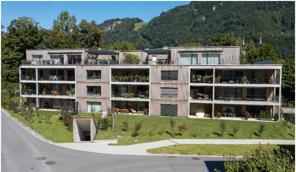
Mehrfamilienhaus Schützenhausstrasse 62, Glarus mit Tiefgaragennotausgang
