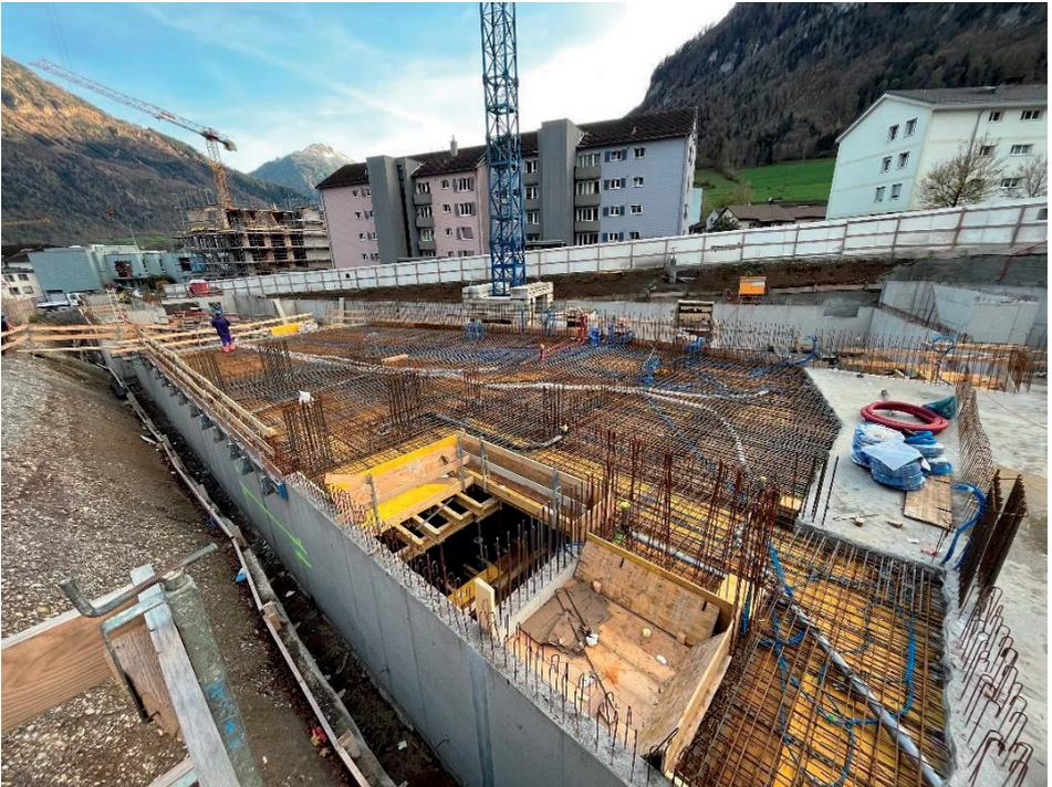
Bild: Deckenarmierung und Schalung des 1. Untergeschosses
