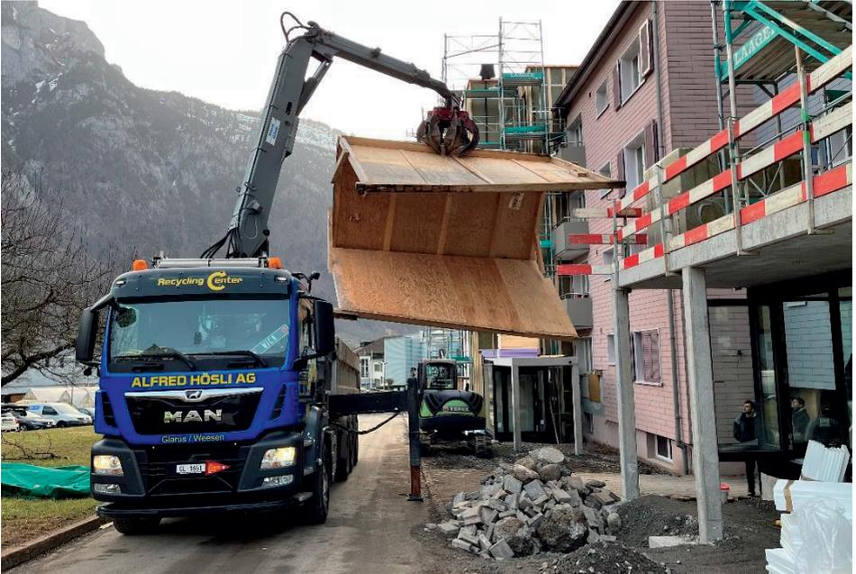
Bild: Der provisorische Eingangsbereich wird wieder demontiert
