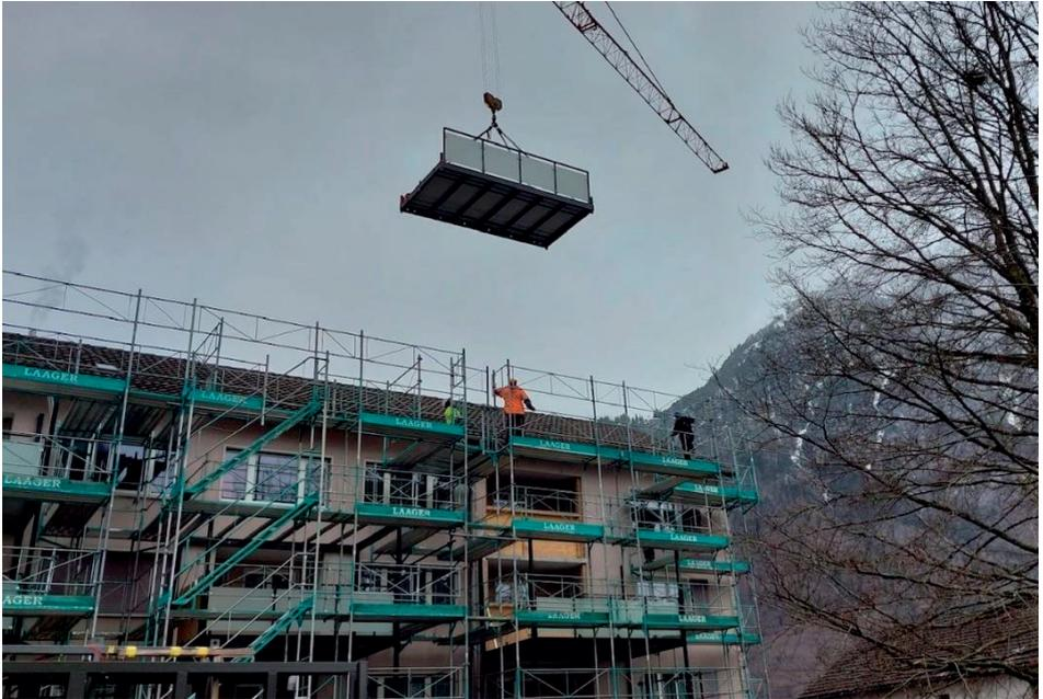
Bild: Anlieferung der einzelnen Balkonelemente
