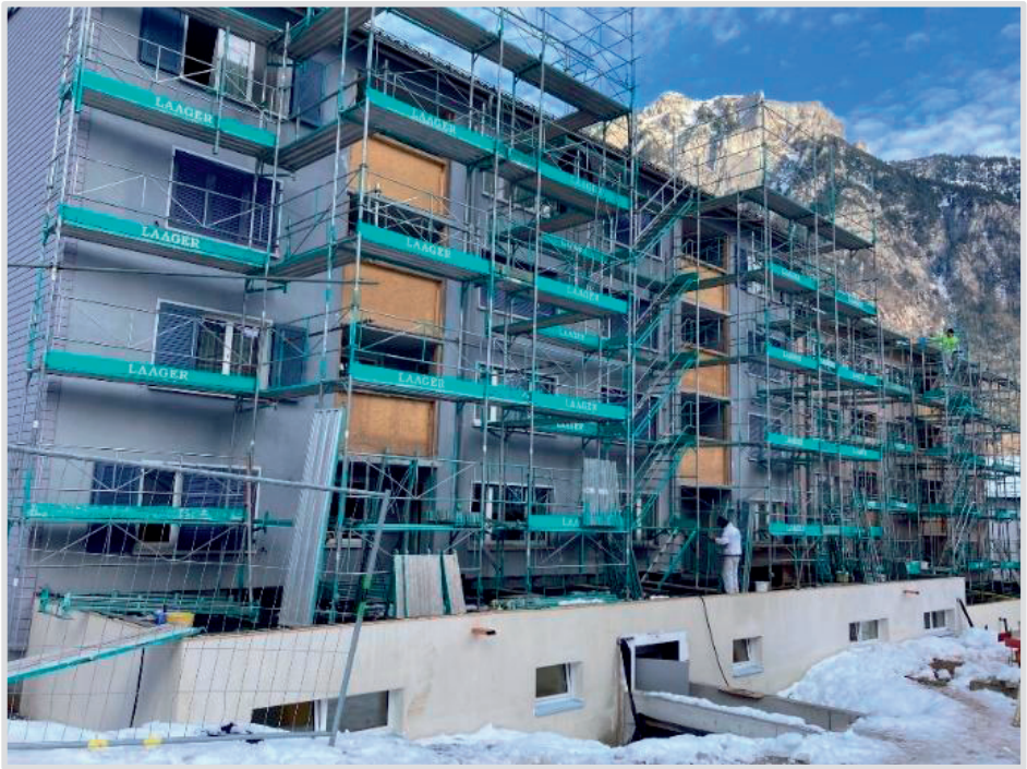
Alles ist bereit für den Anbau der Balkone an der Feldstrasse 9/11 in Glarus
