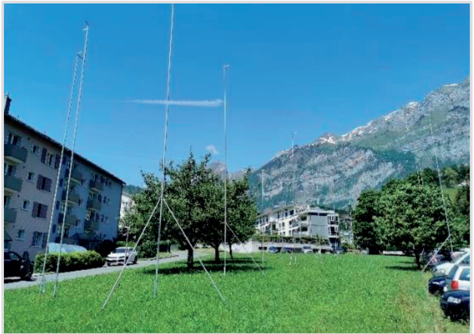
Bauprofile auf der Parzelle 1765
