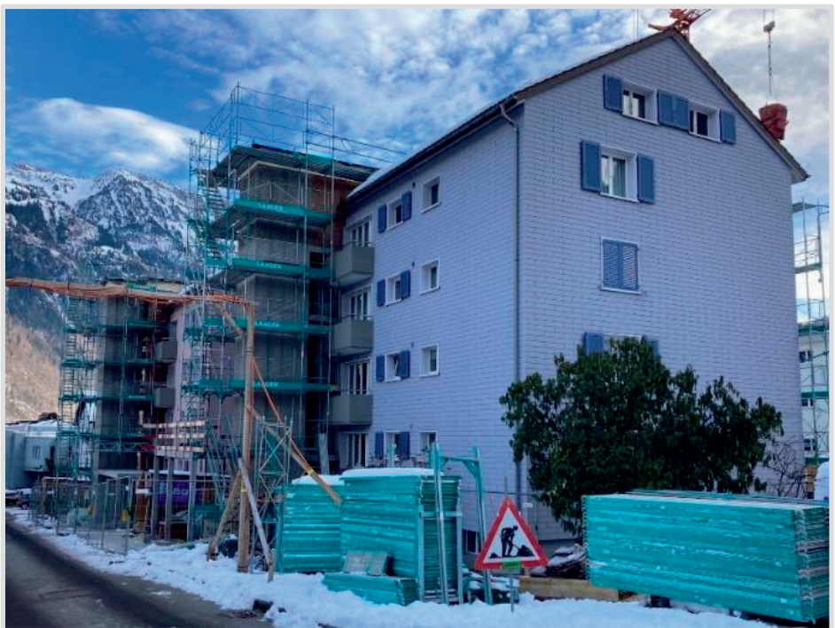
Anbau Liftschächte Feldstrasse 9/11 in Glarus
